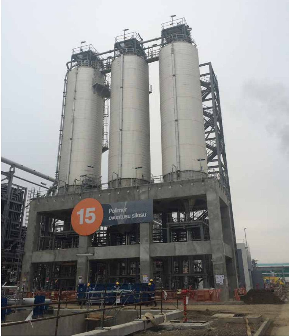
PP zavodu/ MŞ və ÜT: PP- Quru bölmə / PP ovuntusu siloları. Buraxılış-sazlama işləri davam etmişdir
