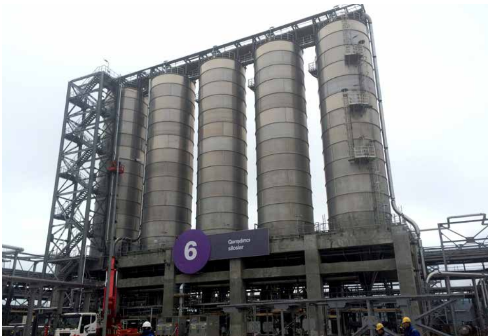
PP zavodu/ MŞ və ÜT: Homogenləşdirmə qurğusu / Qarışdırıcı silolar. Buraxılış-sazlama işləri davam etmişdir
