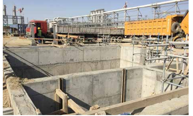
PP / MŞ və ÜT: İzobutan üçün toplama hovuzu. Torpaq doldurma başa çatmışdır. Nasosların quraşdırılmasına başlanmışdır
