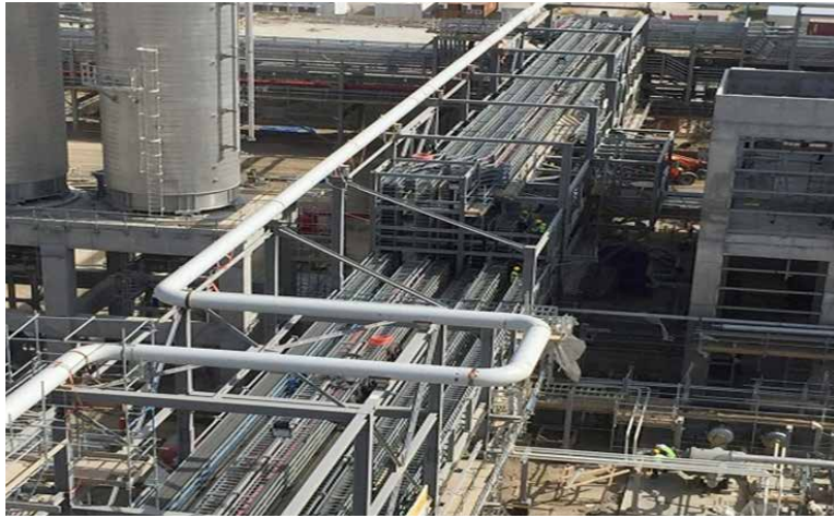
PP / MŞ və ÜT: Birləşdirici boru estakadaları. Boruların quraşdırılması davam edir. Kabellərin çəkilməsinə başlanmışdır
