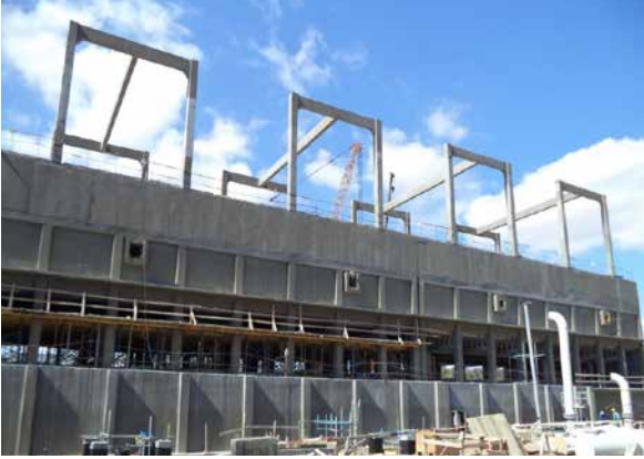
PP / MŞ və ÜT: Soyuducu qüllə. Sprinklerlərin quraşdırılması davam edir. Boruların və avadanlığın quraşdırılması davam edir. Ventilyatorların quraşdırılmasına başlanmışdır
