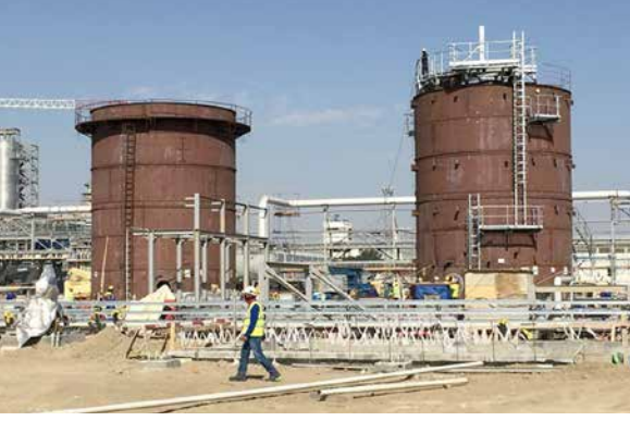
PP / MŞ və ÜT: Heksen rezervuarı. Rezervuarın quraşdırılması davam edir
