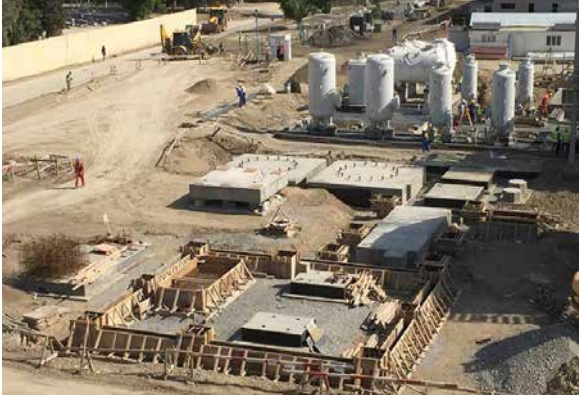
Azot aqreğatı. Rezervuarın quraşdırılması tamamlanmışdır. Avadanlığın quraşdırılması üçün özüllerin hazırlanmasına başlanmışdır
