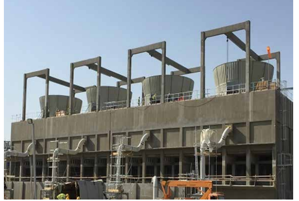
PP / MŞ və ÜT: Soyuducu qüllə. Sprinklerlərin quraşdırılması davam edir. Boruların və avadanlığın quraşdırılması davam edir. Ventilyatorların quraşdırılmasına başlanmışdır
