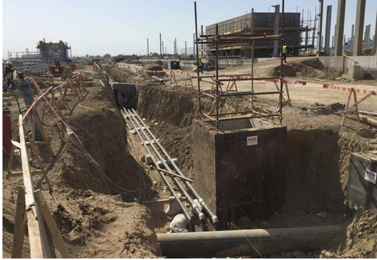
PP / MŞ və ÜT: Yeraltı kommunikasiyalar. Xam su rezervuarı, metal konstruksiyalar, yanğınsöndürmə suyu və zavodun idarə olunma və nəzarət sistemləri üçün nəzərdə tutulmuş boruların və xidmət quyularının quraşdırılması davam edir
