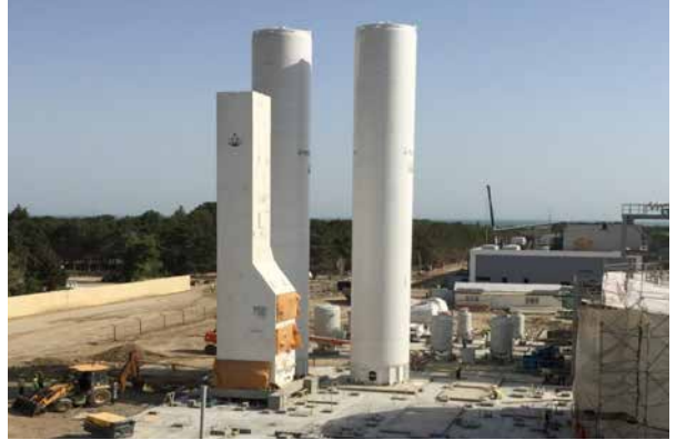
Azot aqreğatı. Rezervuarın quraşdırılması tamamlanmışdır. Avadanlığın quraşdırılması üçün özüllerin hazırlanmasına başlanmışdır
