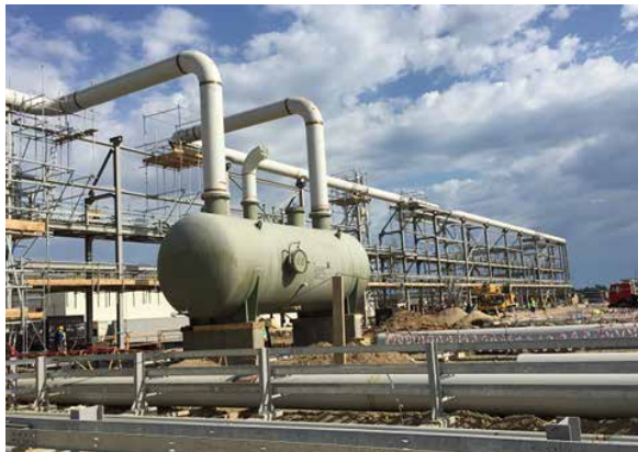
PP / MŞ və ÜT: Meşəl separatoru. Nasos quraşdırılmışdır. Boruların birleşdirilməsi davam edir
