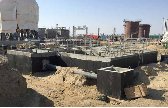
PP / MŞ və ÜT: İzobutan üçün toplama hovuzu. Torpaq doldurma başa çatmışdır. Nasosların quraşdırılmasına başlanmışdır
