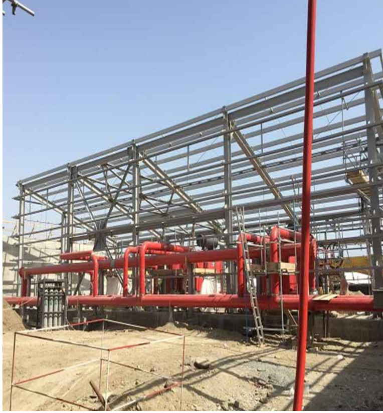
PP / MŞ və ÜT: Yanğınsöndürmə suyu hovuzları və nasosxana. Nasosların və boruların quraşdırılması davam edir. Damda izolyasiya işlərinə başlanmışdır
