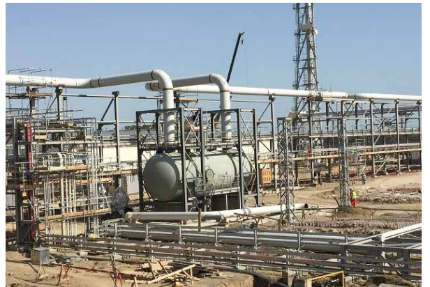
PP / MŞ və ÜT: Meşəl separatoru. Nasos quraşdırılmışdır. Boruların birleşdirilməsi davam edir
