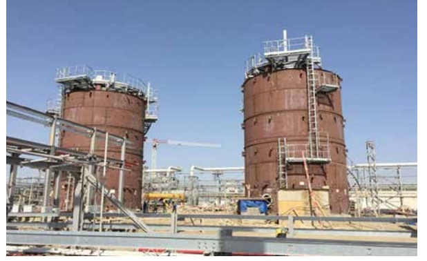
PP / MŞ və ÜT: Heksen rezervuarı. Rezervuarın quraşdırılması davam edir
