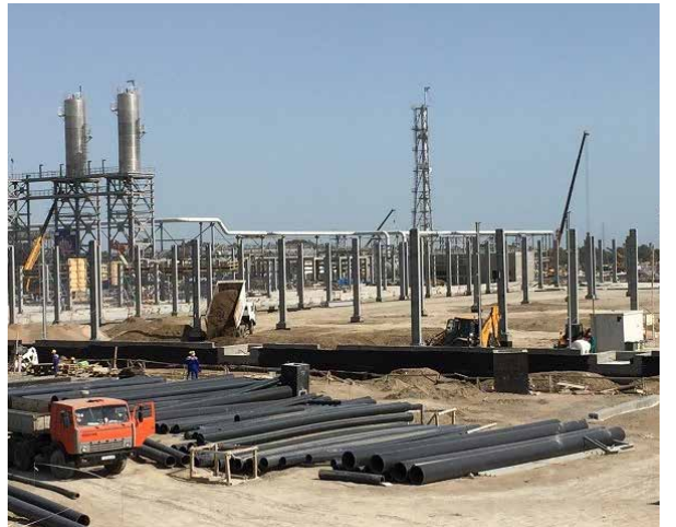
Anbar. Metal sütunların quraşdırılması davam edir. 102 sütun quraşdırılmışdır. Torpağın geri doldurulması davam edir. Ağır yükə davam gətirən döşəmənin çəkilməsinə başlanmışdır. Klapan/siyirtmə bölmesində demir- beton işlərinə başlanmışdır
