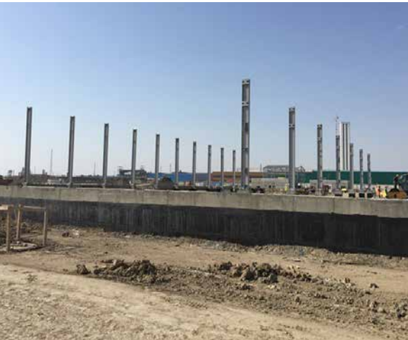
Anbar. Metal sütunların quraşdırılması davam edir. 102 sütun quraşdırılmışdır. Torpağın geri doldurulması davam edir. Ağır yükə davam gətirən döşəmənin çəkilməsinə başlanmışdır. Klapan/siyirtmə bölmesində demir- beton işlərinə başlanmışdır
