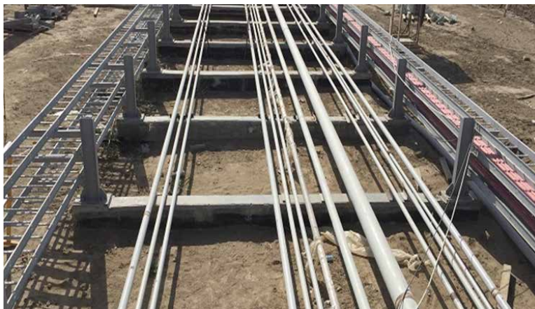
PP / MŞ və ÜT: Boru altı şpallar. Boruların və kabel tavalarının quraşdırılması davam edir. Kabellərin çəkilməsinə başlanmışdır
